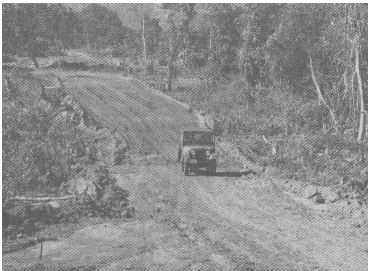
IMAGEM 6: Início de construção da Estrada Santo Aleixo - Piabetá.
