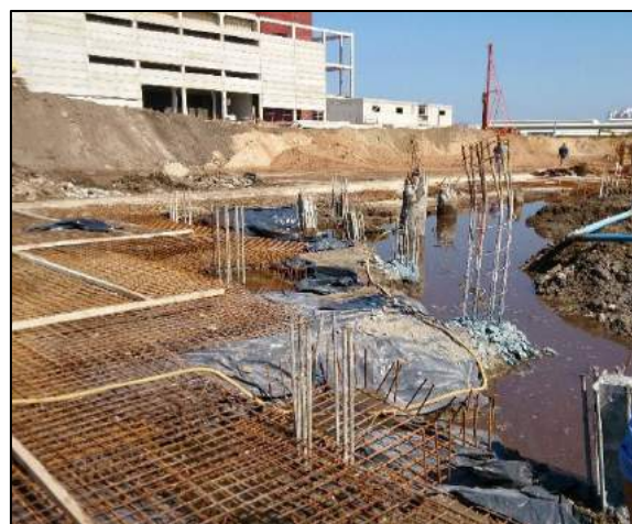
Figura 9: Aterro sobre tabuleiro parcialmente finalizado.
