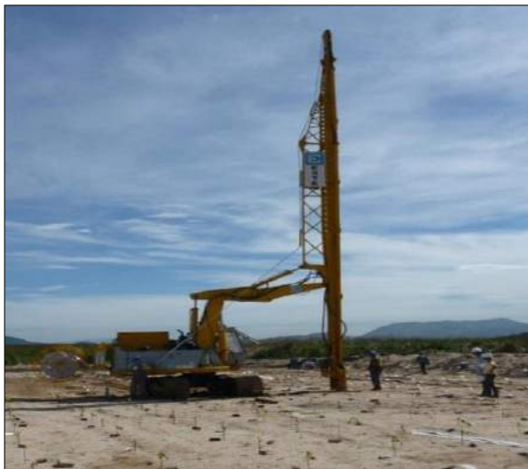
Figura 4: Área durante a execução de drenos verticais.
