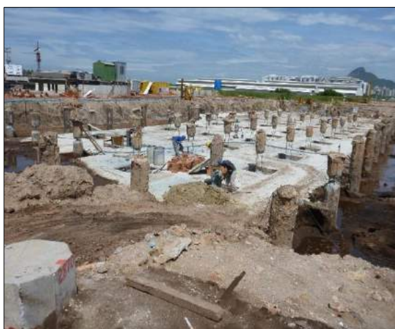
Figura 8: Arrasamento de estacas e magro já executado em um tabuleiro estaqueado.
