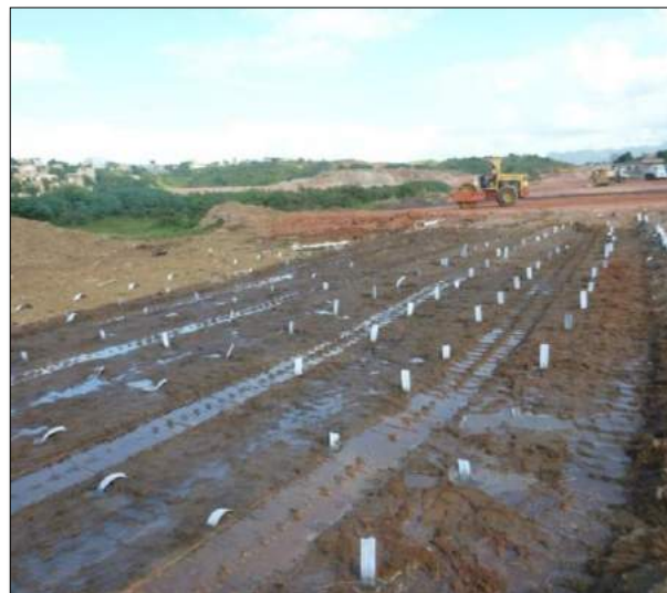
Figura 5: Drenos Verticais recém executados.
