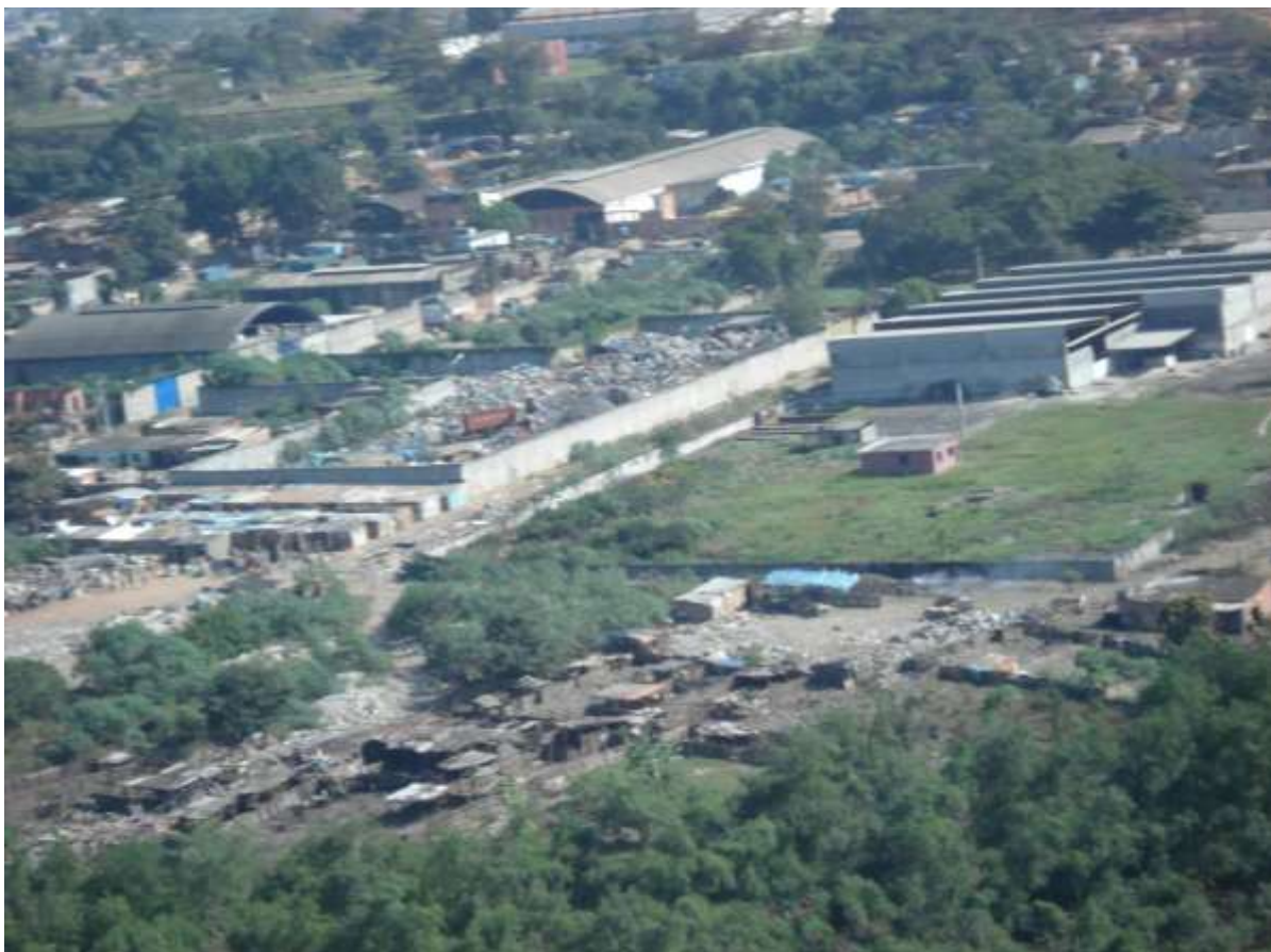
Figura 12 - Depósitos maiores, além da área dos galpões do lado sul da Av. Monte Castelo, próximos à entrada do AMJG, que se instalaram e ampliaram sua área, invadindo áreas verdes (sobrevôo em 28-06-07)
