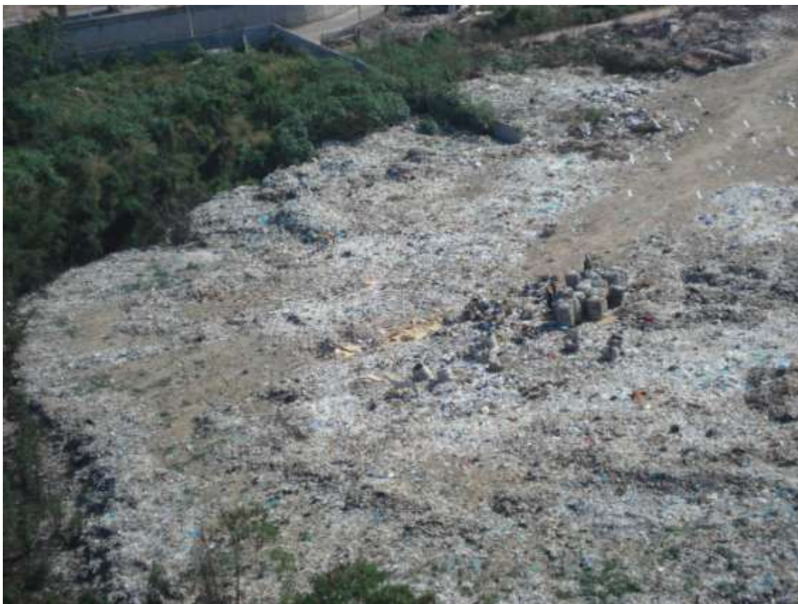
Figura 27 - Muito do material depositado nas frentes de trabalho permanece um bom tempo antes de ser recoberto com material argiloso
