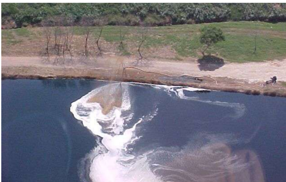
Figura 29 - Aspersão contínua de chorume sobre a lagoa de estabilização de chorume
