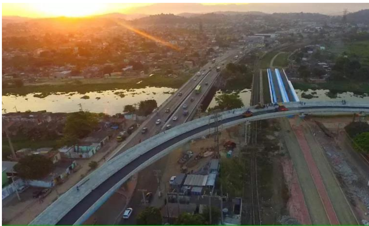
Foto 6: Viaduto do Gramacho
