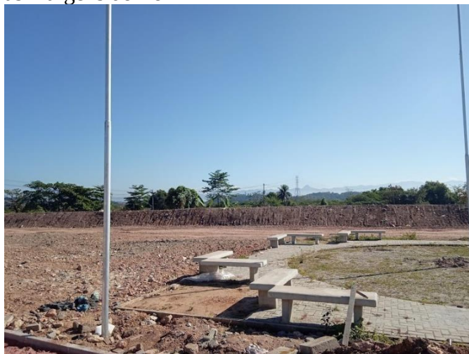
Foto 4: Parque Linear e a construção do dique às margens do rio
