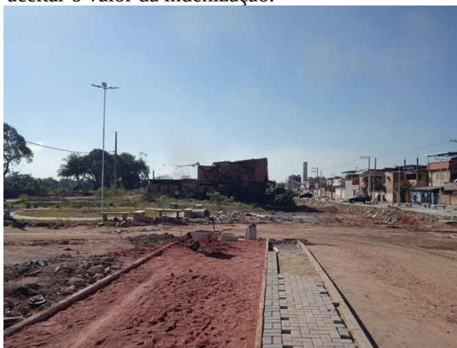
Foto 3: Obras do Parque Linear. A casa do centro da foto foi a que permaneceu por não aceitar o valor da indenização.
