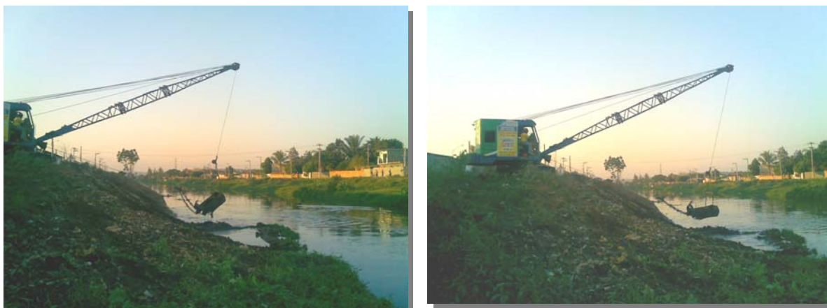
Figura 3.5 - Equipamento em operação na margem de rio da Bota em Belford Roxo
