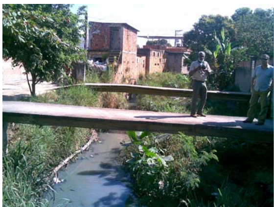
Figura 4.8 - Passarelas de acesso à residências sobre o Rio da Prata em Mesquita.
