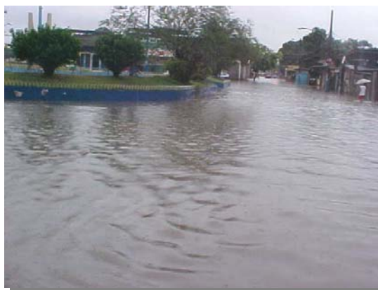
Figura 4.14 - Praça da Bandeira no Distrito de Coelho da Rocha totalmente inundada na temporada chuvosa
