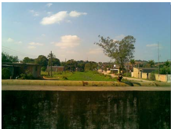
Figura 4.6 - Adutora da CEDAE sobre o Rio Calombé em Duque de Caxias.
