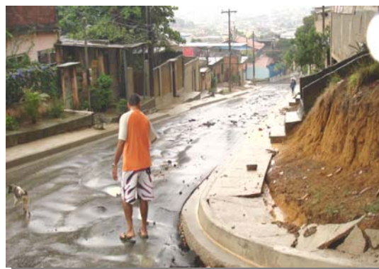
Figura 4.16 - Pavimentação de vias e calçadas danificadas pela enchente.
