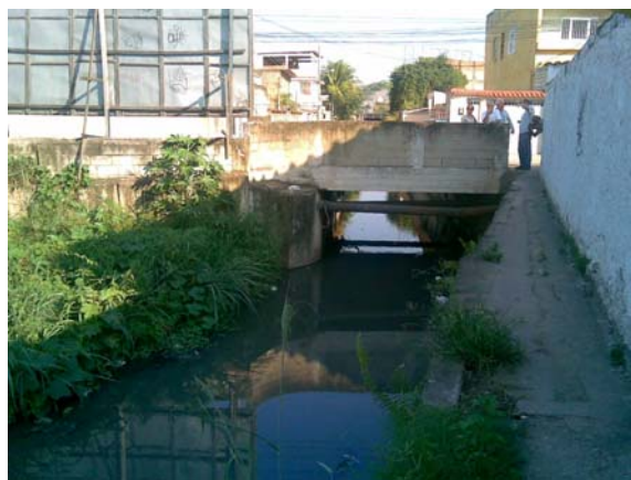
Figura 4.9 - Tubulação de água sob a ponte no Rio Machambomba em Nova Iguaçu.
