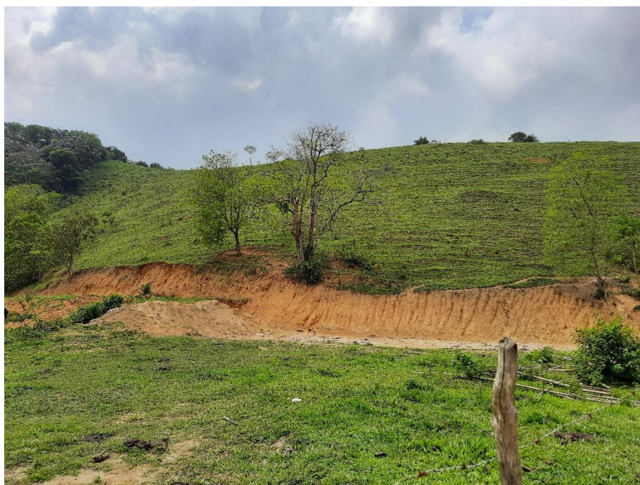
Imagem 22: Vista de área do “Polígono 5” com movimentação de terra, sob as coordenadas 22°36’38.40”S/43°19’38.20”O.
