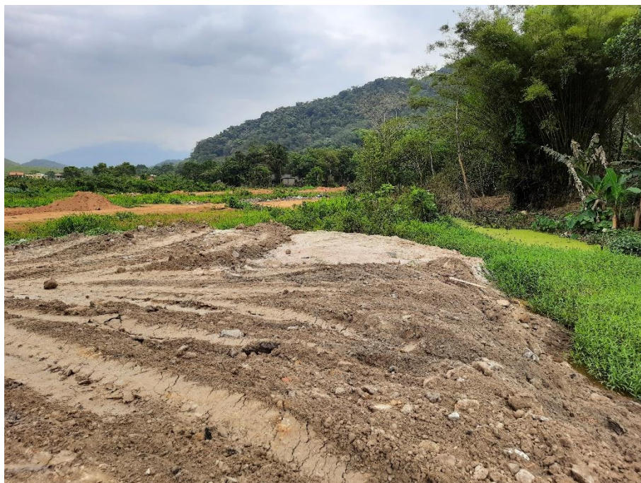
Imagem 34: Vista da área no “Polígono 10” com possível movimentação de terra, sob as coordenadas 22°36'15.90”S/43°19'27.80”O.
