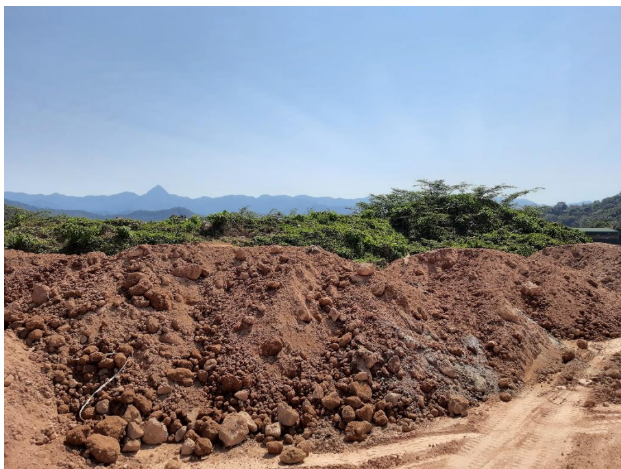
Imagem 40: Vista do “Polígono 14”, área de bota-fora sob as coordenadas 22°37'3.50"S/ 43°17'57.50"O.
