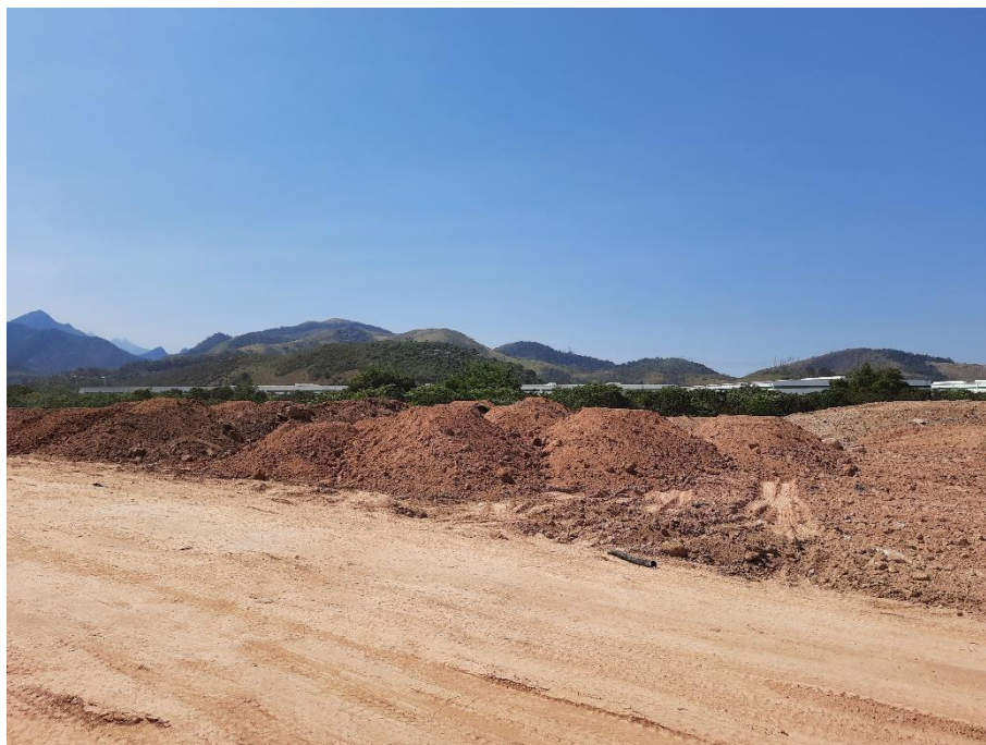
Imagem 41: Vista do “Polígono 14”, área de bota-fora sob as coordenadas 22°37'3.50"S/ 43°17'57.50"O.
