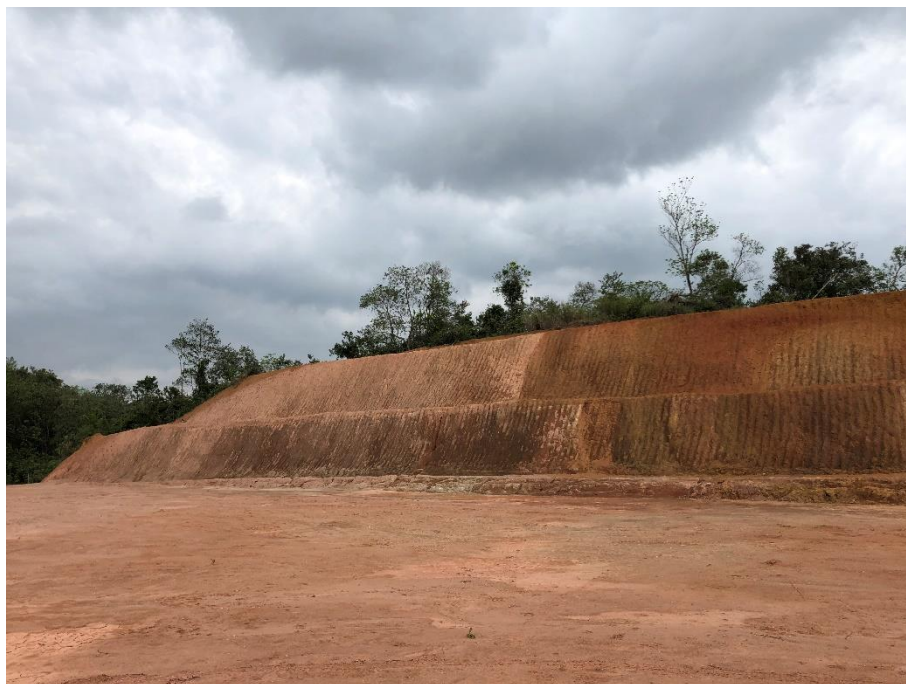
Imagem 9: Vista do “Polígono 2” sob as coordenadas 22°37'18.3’’S/43°20'18.2’’O
