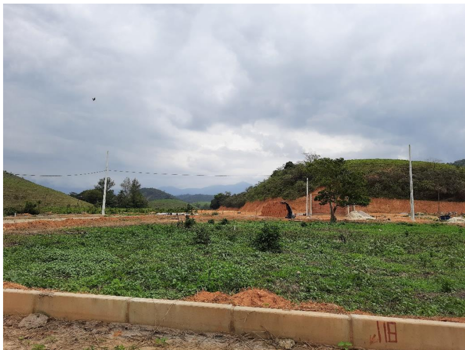
Imagem 30: Área de implantação de loteamento no “Polígono 8”, com acesso pela Estrada São Lourenço.
