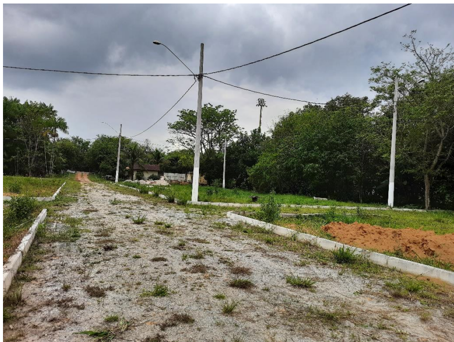
Imagem 27: Vista de loteamento no “Polígono 8”, sob as coordenadas 22^{\circ}36'33.1''\text{S}/43^{\circ}19'52.8''\text{O} .
