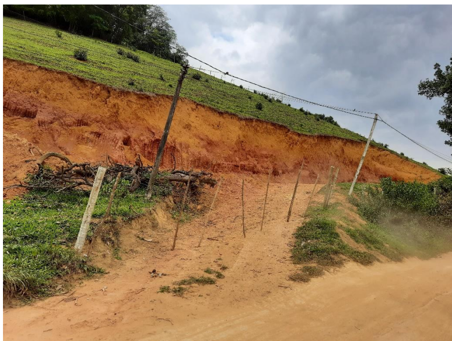
Imagem 24: Área cercada do “Polígono 6” com movimentação de terra, sob as coordenadas 22°36’28.10”S/43°19’38.50”O.
