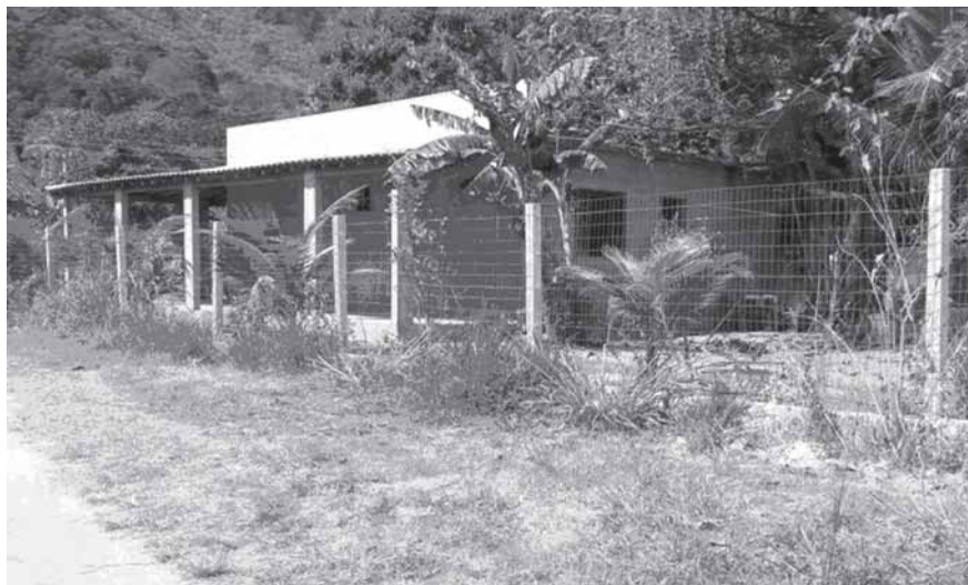
Figura 4 – Exemplo de construção irregular em área de mangue, registrado em setembro de 2015.
